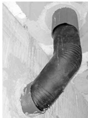
← Esempi di attraversamento solaio con guaina disaccoppiante.
