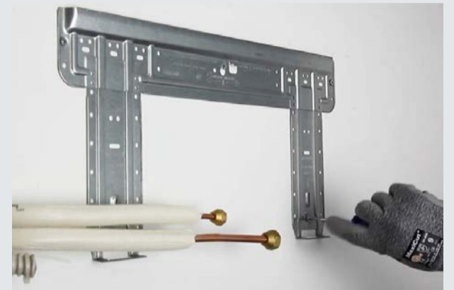
6. FISSARE la piastra di montaggio e avvicinare i tubi in rame provenienti dall'unità esterna
