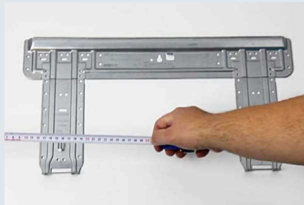
5. INDIVIDUARE le posizioni dei fori (riportate sul manuale d'installazione a seconda del modello dell'unità) aiutandosi con un metro
