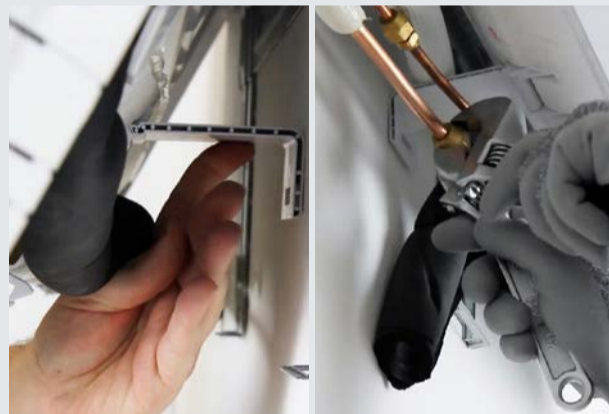
8. TRAMITE il sistema Easy Clip, è possibile tenere ferma l'unità per collegare e stringere i tubi provenienti dall'unità esterna con un ampio spazio di manovra
