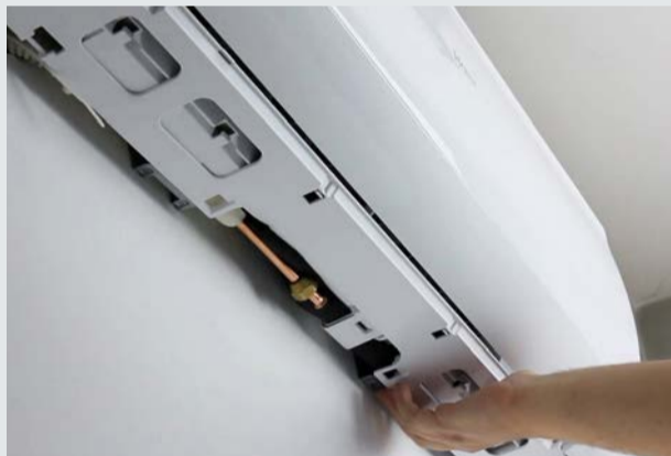
7. AGGANCIARE l'unità alla piastra di montaggio
