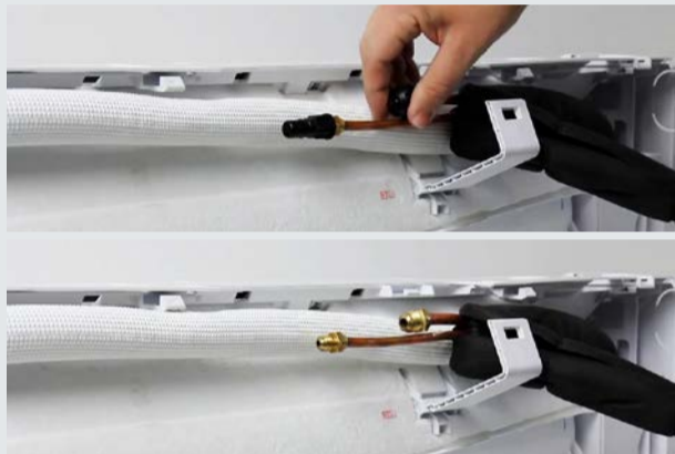
4. ESTRARRE i tubi per il collegamento del gas refrigerante e rimuoverne le protezioni
