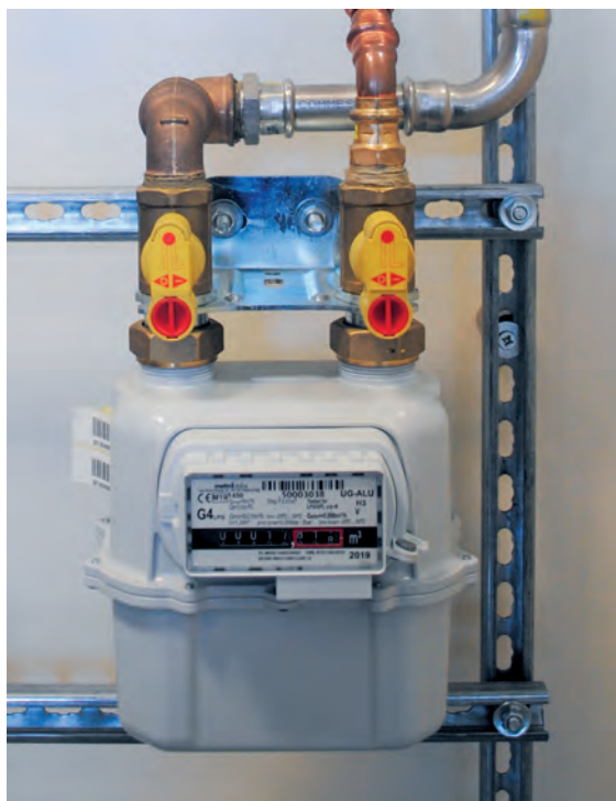
Figura 4.1 – Contatore tipo G4.
